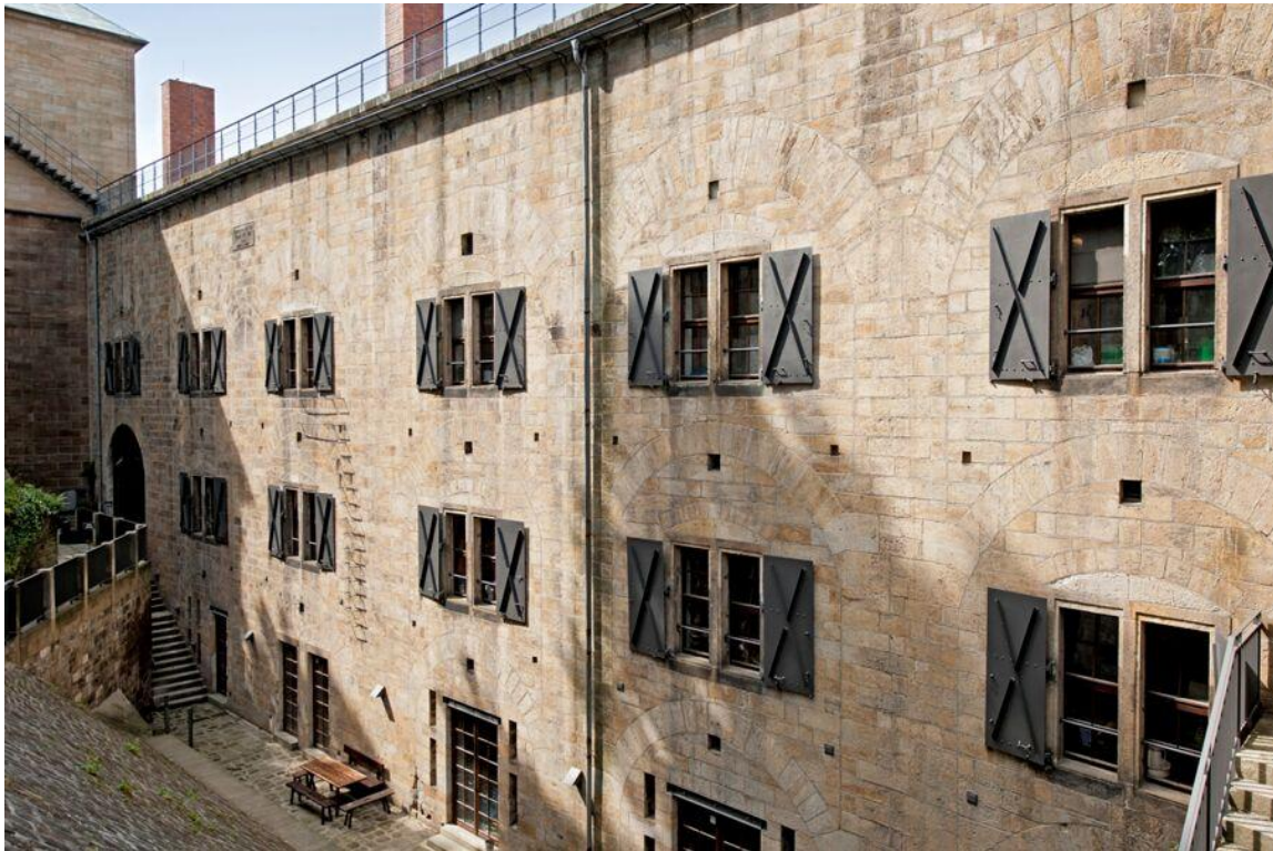
Außenansicht des Restaurants in den Kasematten
